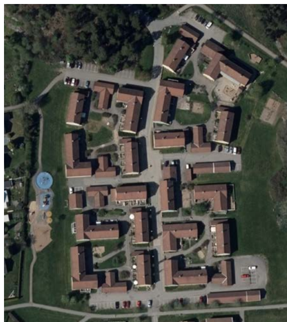
Ortofoto över Ströms väg, Rosen 1, i Söderköping visar ett modernt exempel hur flera flerbostadshus i lantlig stil bildar gårdar. Strukturen upprepas och bildar ett eget område. Källa lantmäteriet.
