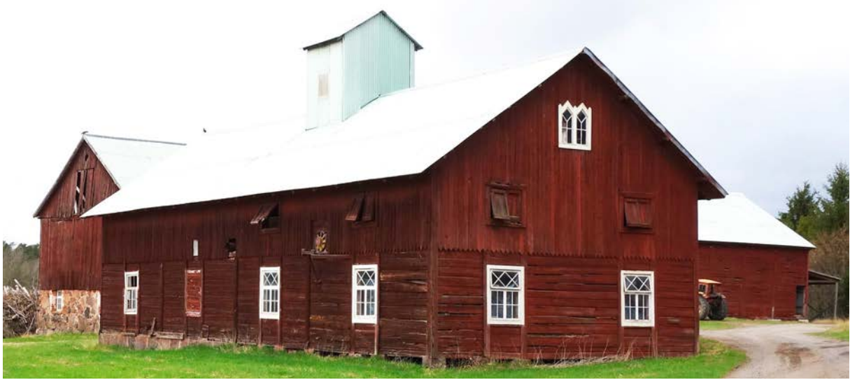
Liggande skiftesverk och stående panel på nedre respektive övre delen av byggnadens fasad. Detta kan vara en inspiration för hur man delar upp fasaden i liggande och stående panel.
