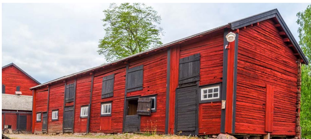
Foto på knuttimrad ladugård. De svarta knutskåpen delar in byggnaden på ett radbusliknande sätt.
