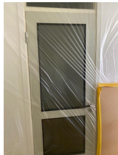
Bild 3: Inplastning av väggar
