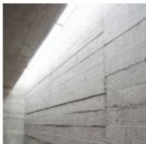
BETONGGRUND OCH MURAR
