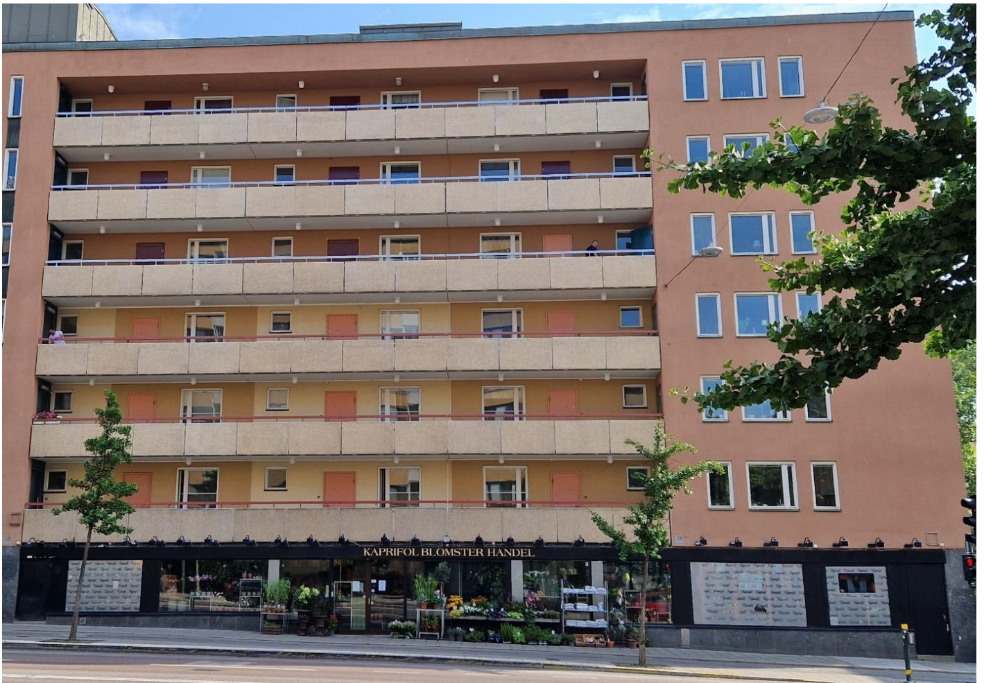
Hornsgatan under ommålning 2022. Överst syns de nymålade loftgångarna: fasad, dörrar och räcke.
